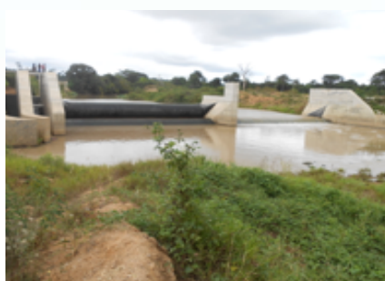
Barrage Gonflable de M'BAHIKRO
