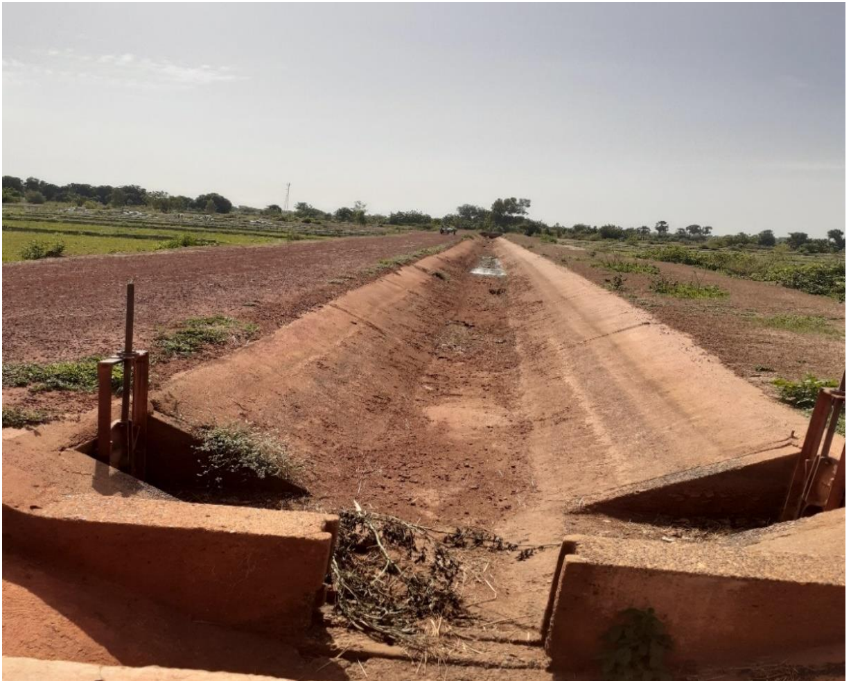
Lot 2: Revêtement canal secondaire Baguinéda
